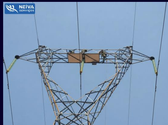
INSTALACIÓN DE SISTEMA ANTIPOSAMIENTO (LÍNEA VI)
